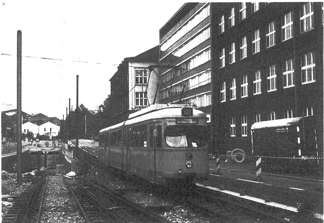
Triebwagen 1854 an der Tunnelrampe am Haupteingang
