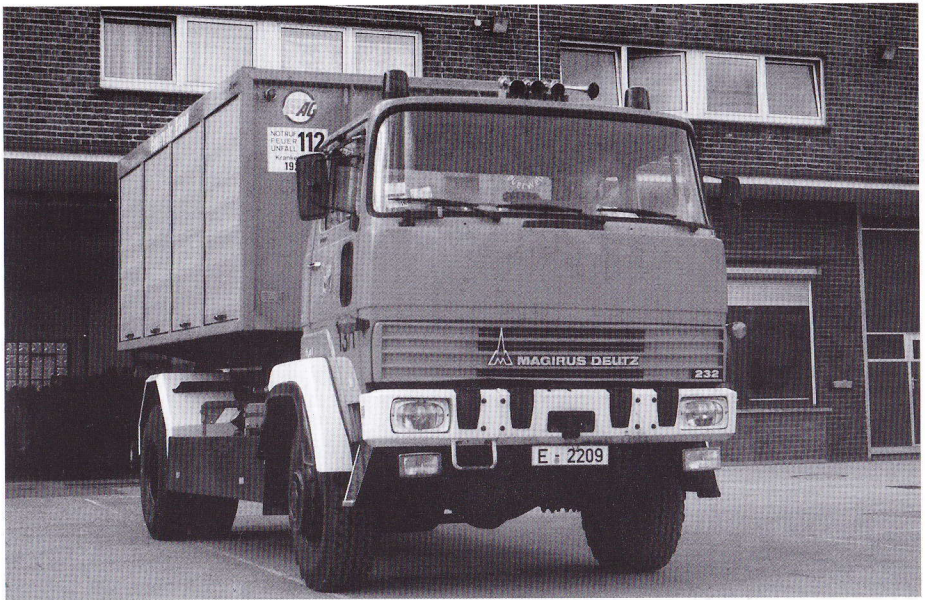
Oben: Magirus-Deutz Trägerfahrzeug der Berufsfeuerwehr Essen mit einem "Wechselaufbau EVAG" (WAB-EVAG).
